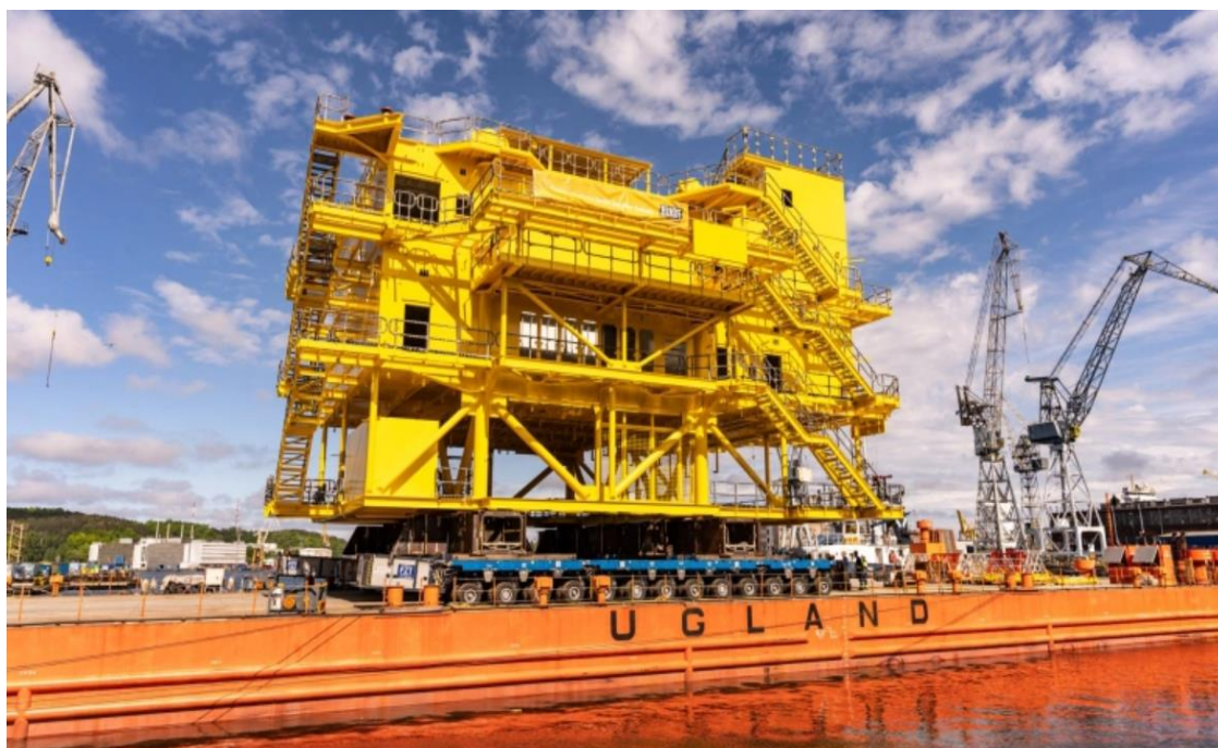
Rysunek 19. Konstrukcja stalowa morskiej stacji transformatorowej dla projektu MFW Kaskasi na Morzu Północnym, (źródło: Energomontaż-Północ Gdynia S.A.) [dostęp: 05.2021]
