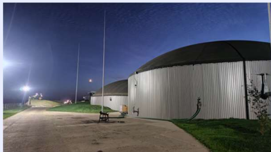
Elektrownia biogazowa w Mątowach Małych o mocy do 500 kW.
