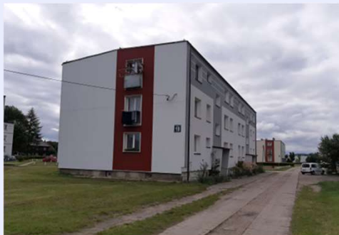
Spółdzielnia Mieszkaniowa „Bożepole”, gruntowe pompy ciepła dla 14 budynków wielomieszkaniowych.
