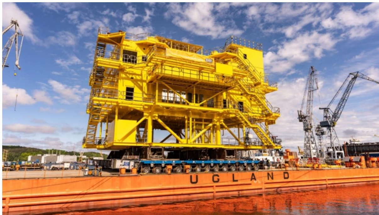
Rysunek 13. Konstrukcja stalowa morskiej stacji transformatorowej dla projektu MFW Kaskasi na Morzu Północnym, (źródło: Energomontaż-Północ Gdynia S.A.)
