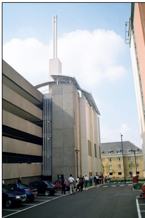
Stacja Energetyczna Centrum Miasta (CHP)
