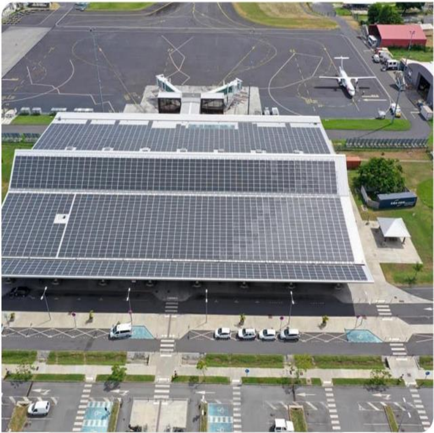
0.9MWp + 0.7MWh baterii na lotnisku Majotta
