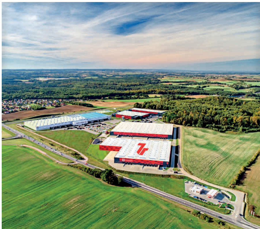
Dekpol dla 7R zbudował w Swarzędzie nowoczesny park magazynowy o powierzchni prawie 40 tys. metrów kwadratowych.
