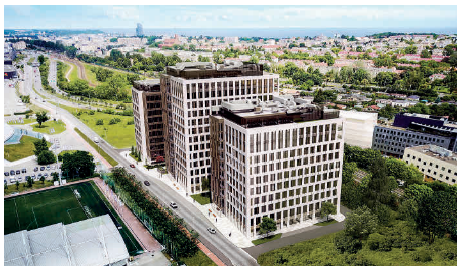
Największa obecnie inwestycja w Gdyni, 3T Office Park
