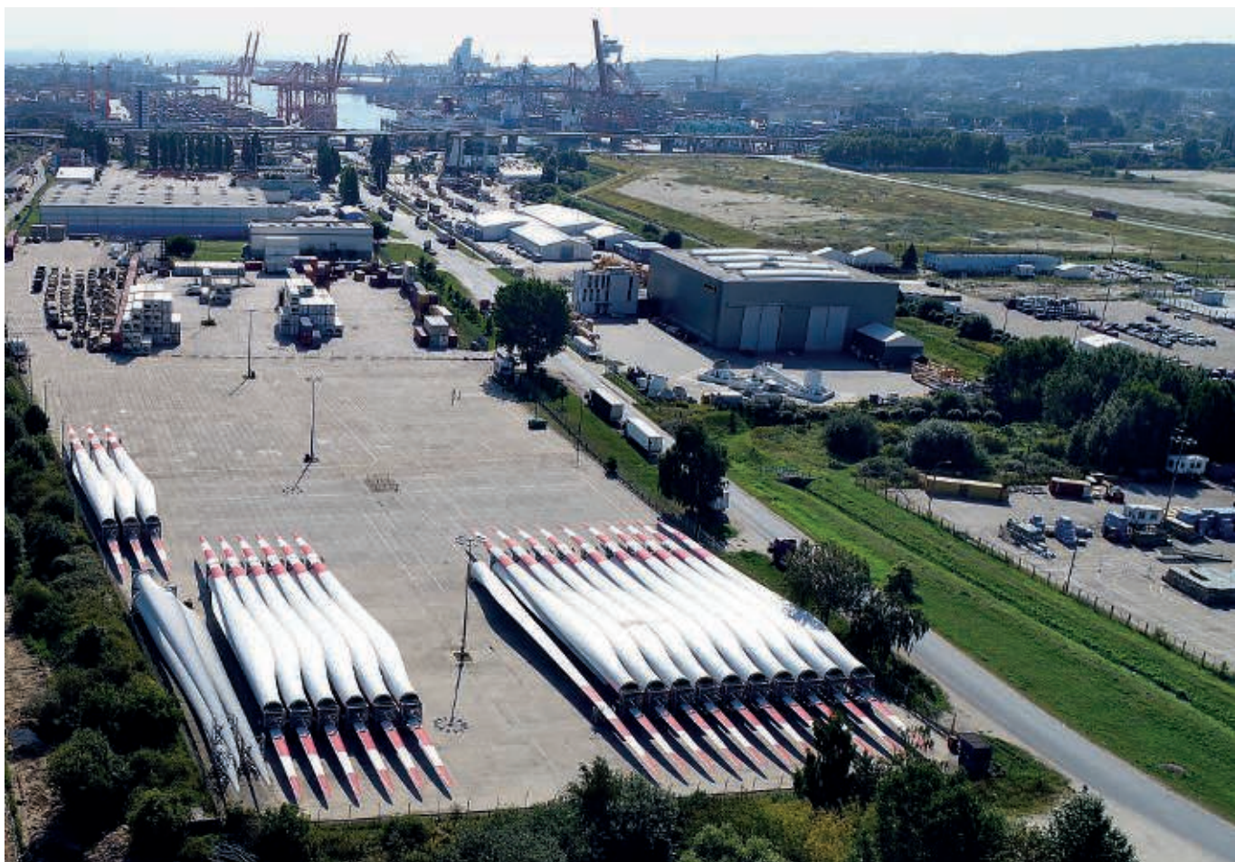
Port w Gdyni może być portem instalacyjnym dla planowanych na polskich wodach farm wiatrowych
